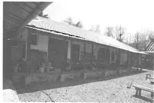
[사진 18] 김소촌가 전경
